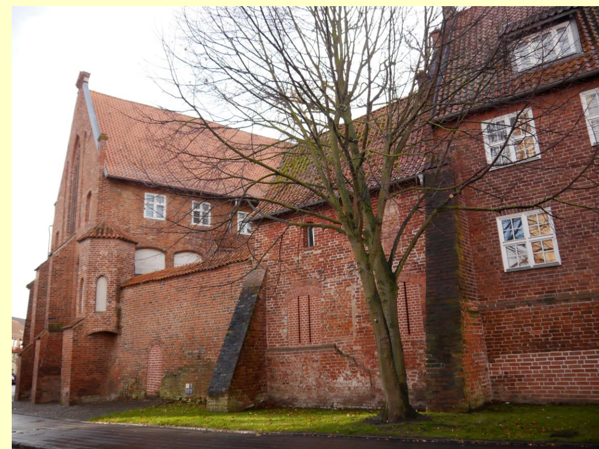
Abb.2: Sicht auf die Klosteranlage (West)
