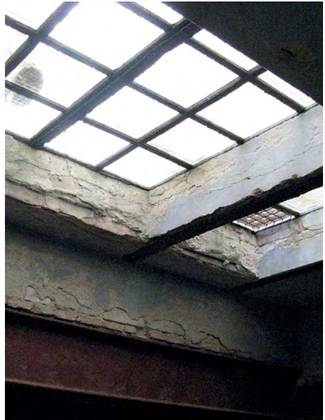
127 Ansicht des südlich Bereichs der Gruftdecke, ausgeführt mit Luxferprismen, 2010, Foto: Tjalda Eschebach.
