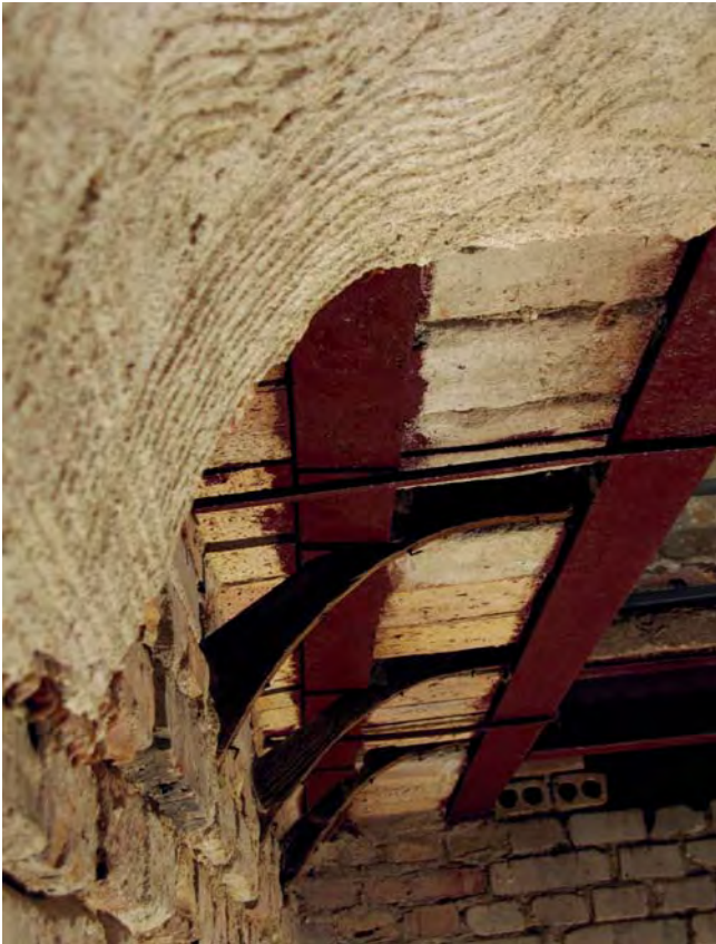
128 Detail der Deckenkonstruktion im Oberbau; Voute, Foto: Annett Baack.
