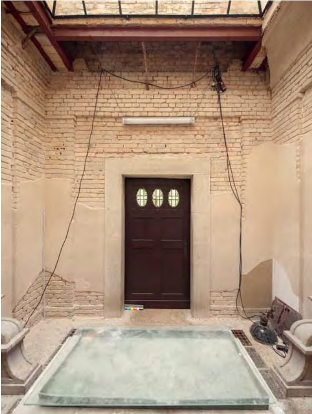
124 Blick auf die Nordwand des Oberbaus im Mausoleum, 2010. Foto: Friedemann Steinhausen.
