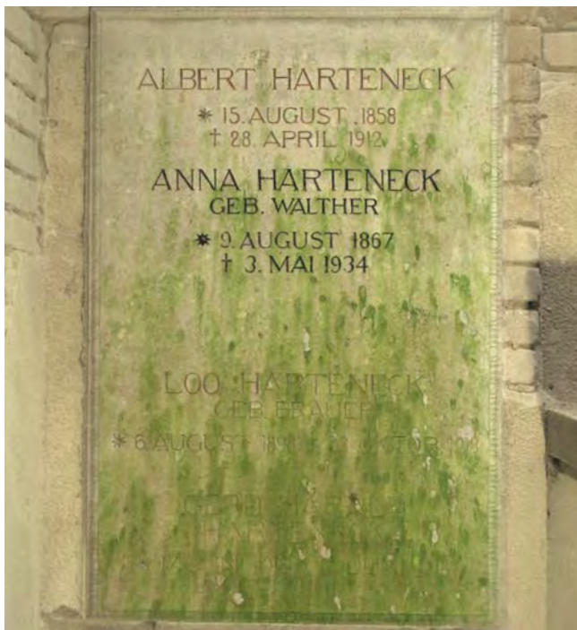
121 Grabinschriftenplatte im östlichen Bereich der Südwand, Zustand 2010, Foto: Tjalda Eschbach.
