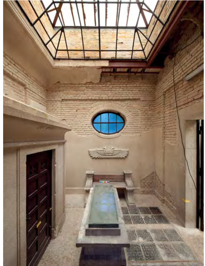
125 Blick auf die Westwand des Oberbaus im Mausoleum, 2010. Foto: Friedemann Steinhausen.
